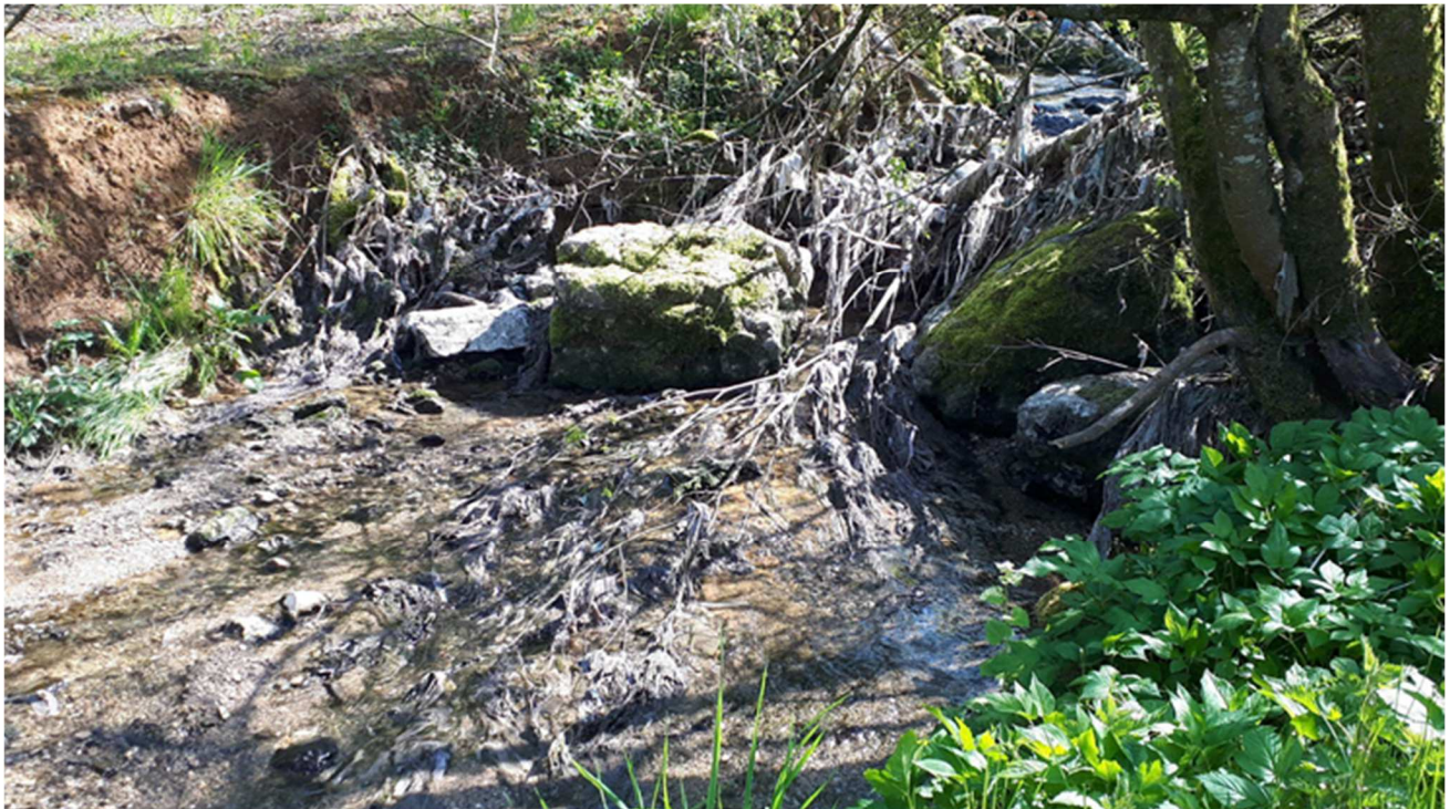
Photo en aval de la commune de Beaucourt avec plus de 50% de réseau Unitaire
