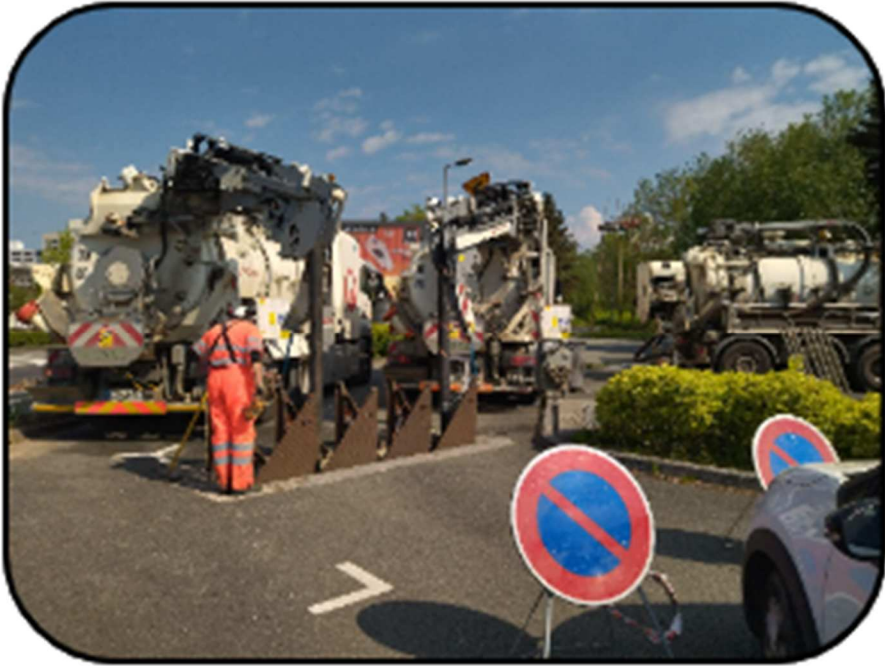
Réparation du refoulement du PR Temple Pont François Mitterrand à Audincourt
